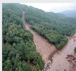
2011년 7월, 폭우로 인해 우면산에서 산사태가 발생하여 다수의 시민이 고립되고 18명의 사망자가 발생함. 인근 아파트 2천 가구가 정전되고 2만 5천여 가구가 단수됨
