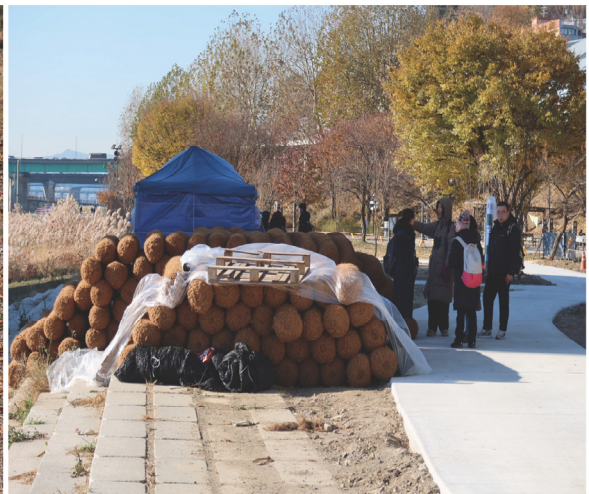
2023년 12월 산책로 정비 후 야자매트 공사 준비
